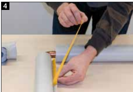
4 Ablösen des Trennstreifens und verkleben der PVC Folie (Untergrund muss trocken, staub- und fettfrei sein, Verarbeitungstemperatur sollte zwischen +10°C und +35°C liegen)
