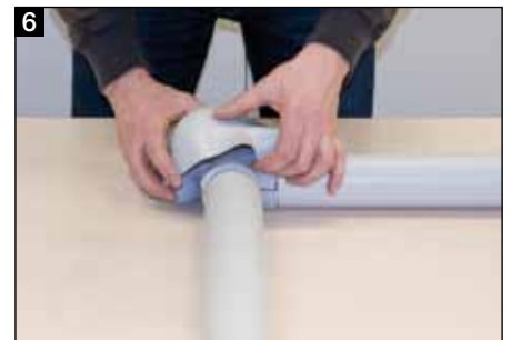
6 Dämmung der Formstücke: Montage des Melaminkernes und PVC Mantels
