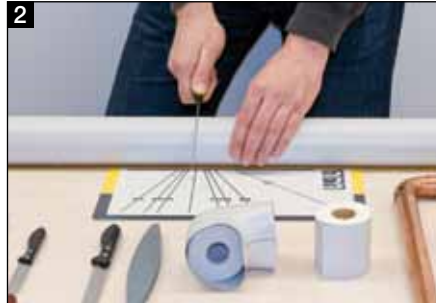
2 Zuschneiden der KAIFOAM PUR Schalen
