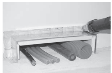
Einmörteln mit Hilfe einer Mörtelspritze am Beispiel einer UFK Kabelbox
