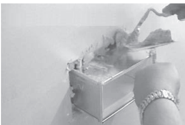
Einbau mit Gips und einer Kelle am Beispiel einer Kabelbox
